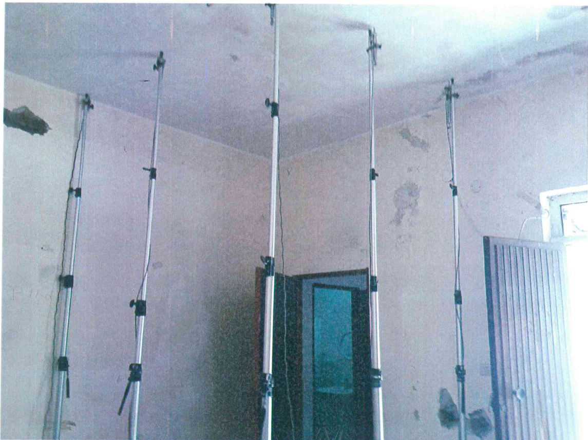
Panoramica sulla disposizione dei punti di misura
